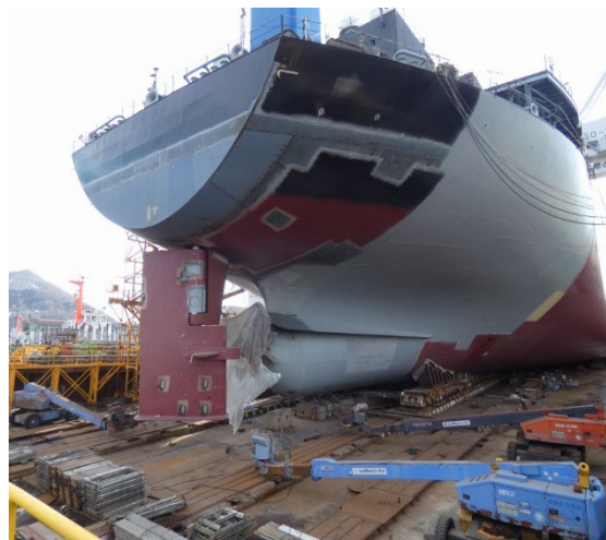
船台で組み上げられた船体 （記事より抜粋）
