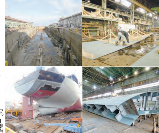
(左から時計回り)近代化産業遺産の第1号乾ドック、組立作業が本格化する巨大なブロック、組立作業が本格化する巨大なブロック、組立作業が本格化する巨大なブロック
